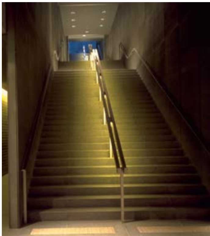
Pentru scara de acces s-a utilizat lumină ambientală indirectă, încastrată în balustradă.
