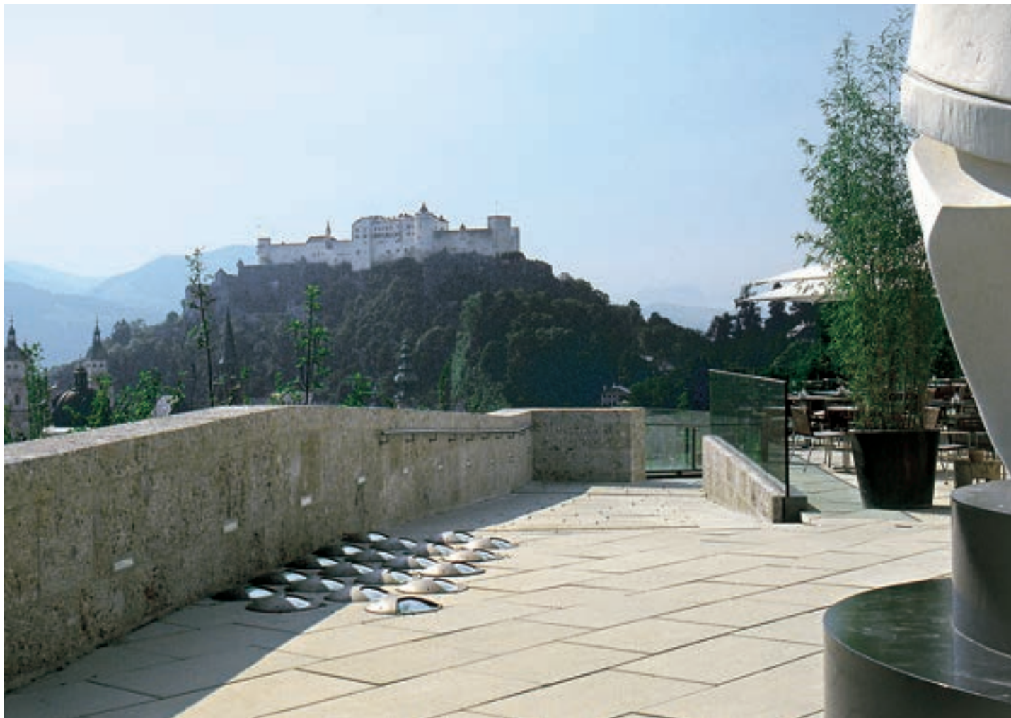
Corpurile de iluminat încastate au fost montate grupat pentru iluminarea clădirii din patru părți
