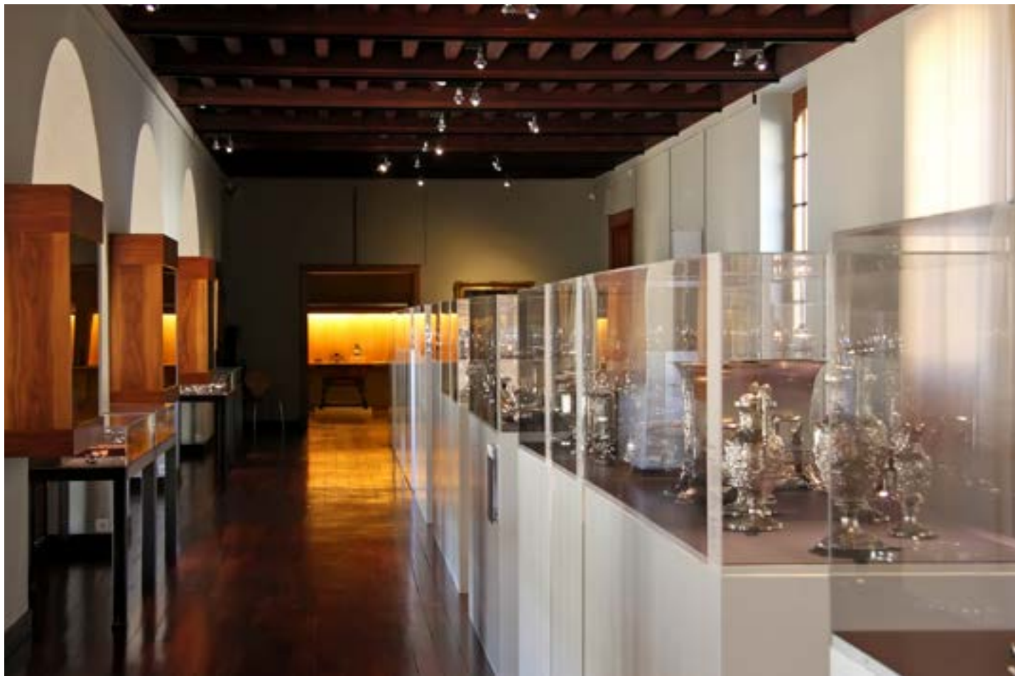
Iluminat de accent cu proiectoare montate pe șină
